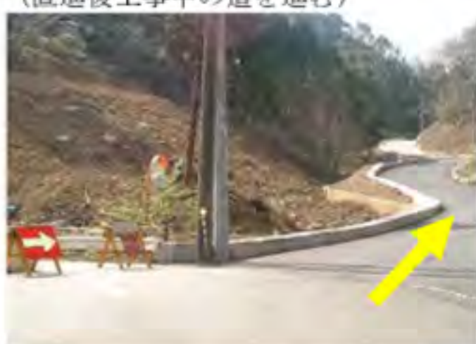
写真 13 道なりに直進中 (直進後工事中の道を進む)
